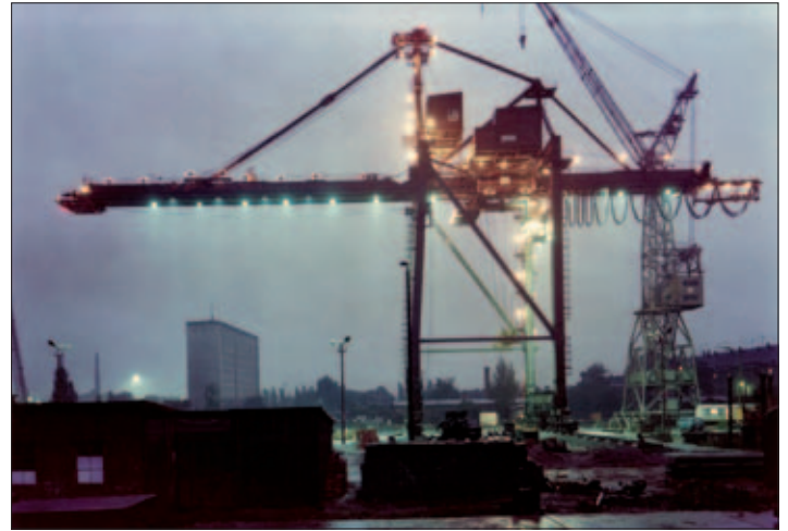
Montage eines Containerkranes im VTA-Betriebsteil Eutritzsch 1972 am Tage und bei Nacht Quelle: Sächsisches Staatsarchiv Leipzig, Bestand VEB Verlade- und Transportanlagen Leipzig.
