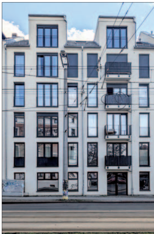
◀ Teil der neuen Delitzscher Straße 28 mit Zugang zum Haus, am 11. März 2026
