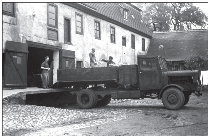
Foto: Karl Heinz Mai: Dölitzter Wassermühle, Leipzig, Vollhardt-straße 16, 1953
