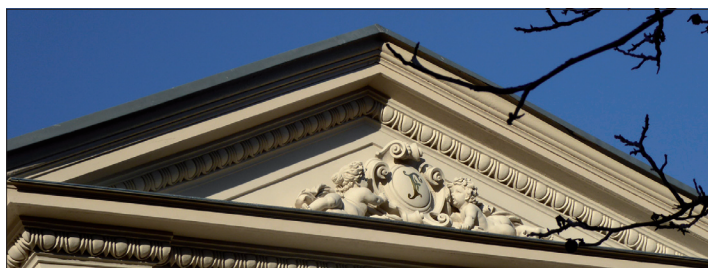
Detailansicht des straßenseitigen Giebels, Januar 2020
