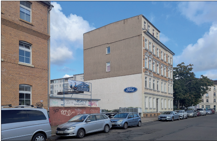
Die Lücke in der Haferkornstraße 17, am 24. September 2026
