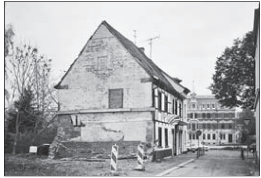
Die Seitengasse 6 nach dem Abbruch der Gebäude 4 und 5, 2003
